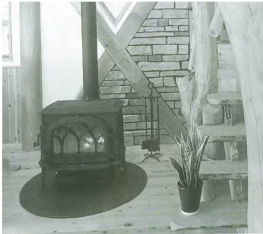
円形の鉄板のシンプルな炉台。壁から離れていれば、これだけでも十分。四方に熱が行くので暖房効率も高い
