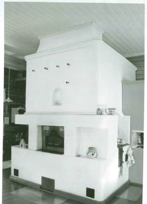
右／フィンランドの古いログハウスにあっ た薪ストーブ。これ一台で暖房も調理も 賄える。上部に見えるネジのようなもので、 空気量を調節する 左／こちらもフィンランドの薪ストーブ。築 100年以上のログハウスのものだけに、 とても味がある。もちろん、現役だ
