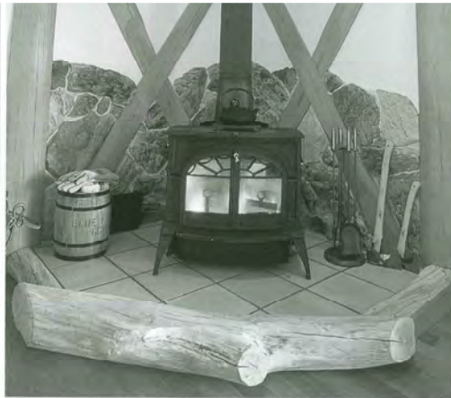
筋交いが入ったポスト&ビームの壁に、石を埋め込んだ例。炉台の枠が枝つき丸太というのがいい
