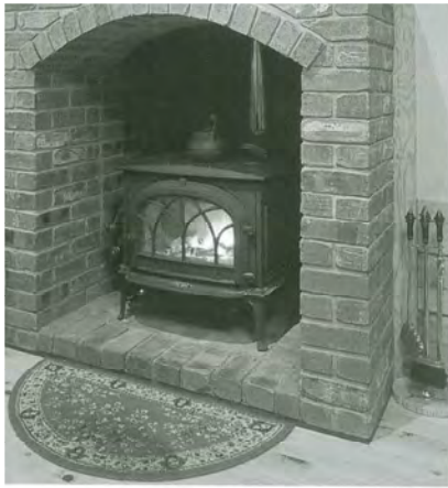
ヨツールの薪ストーブを、欧米風にレンガで囲い込んだシックな炉台。煙突も壁の中に入っている
