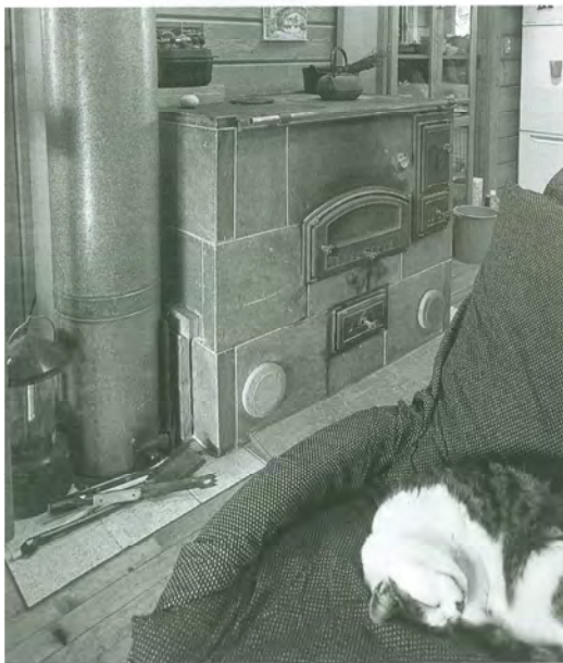
フィンランドの一般家庭でよく使われている薪ストーブ。素材が石なのでじんわり体が温まるのだ
