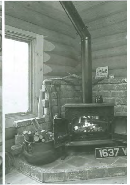
レンガを積んでつくった手づくりの炉台。薪を置いておくスペースもしっかり考えられている
