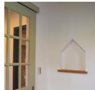
⑦1F玄関室 漆喰壁に家形のニッチェを作った
