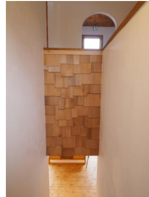
⑪2F階段室 貼ったのは外壁用/屋根用のレッドシーダーシェイク材
