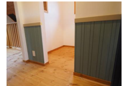
⑭2F廊下 腰板は床材の余り、わざと裏側の溝のある面を表に使い意匠にしたところが、施主さんのセンス
