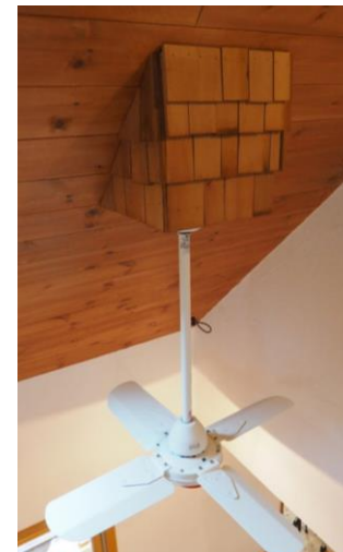
⑮2F吹抜け天井 シーリングファンの台にもレッドシーダーシェイクを貼った。山小屋の気分です
