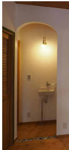
⑤1Fリビング、アーチ開口の漆喰壁、猪瀬大工に作り方を教わり曲げベニヤで下地を作り漆喰を塗る
