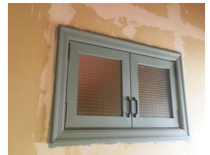
⑯2F廊下 ⑩同様、ネットで買ったチェッカーガラスで自作した明り取り窓。巾木と窓の額縁の余り材で製作
