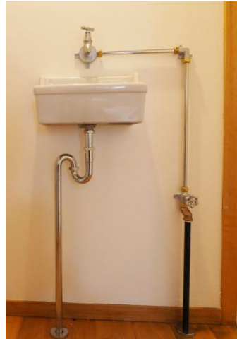
④1F廊下、エッセンスの外付け給水管の手洗い、実にレトロ
