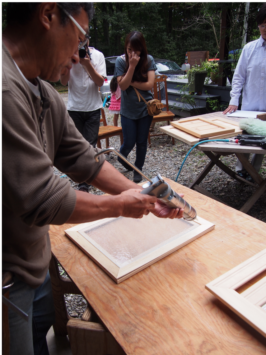
ガラスを固定するためガラスの周りにコーキングする
