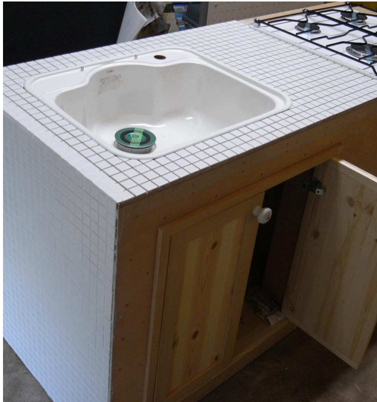
↑ オーバーシンクがワークトップにセットされた (2009年手づくりキッチン教室)
