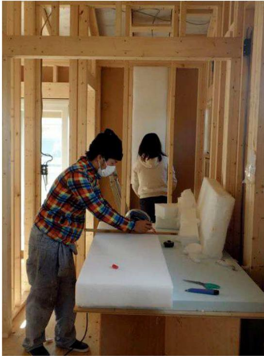
2013年11月13日 断熱材ペットウールを壁と天井に入れる仕事が
