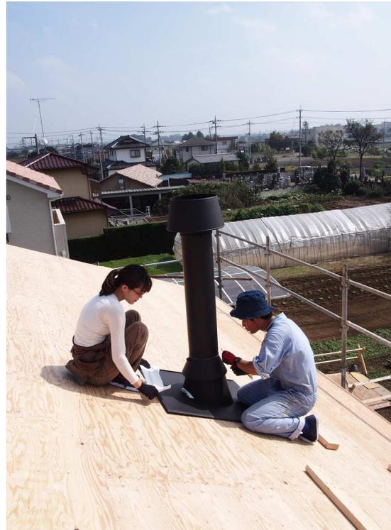
2013年10月8日 上棟工事の5日後、屋根に上がって薪ストーブ煙突を取り付けた
